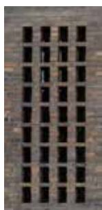
Referencefotos der viser eksempler på fletmurværk, der fungerer som afkast for indvendigt ventilationsanlæg.
