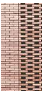
Referencefotos der viser eksempler på fletmurværk, der fungerer som afkast for indvendigt ventilationsanlæg.
